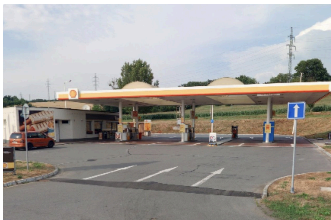
Vjezd do areálu a přístřešek
